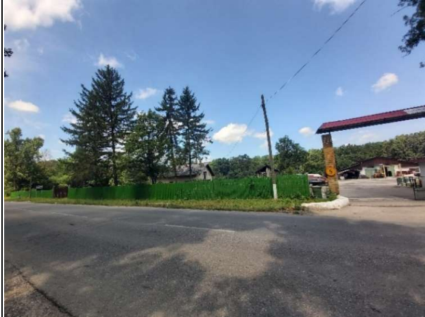
Foto 21. Construcții la marginea drumului pe traseul conductei din ampriza DJ601.
