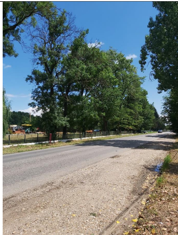
Foto 24. Construcții la marginea drumului pe traseul conductei din ampriza DJ601.
