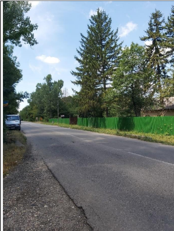
Foto 19. Construcții la marginea drumului pe traseul conductei din ampriza DJ601.
