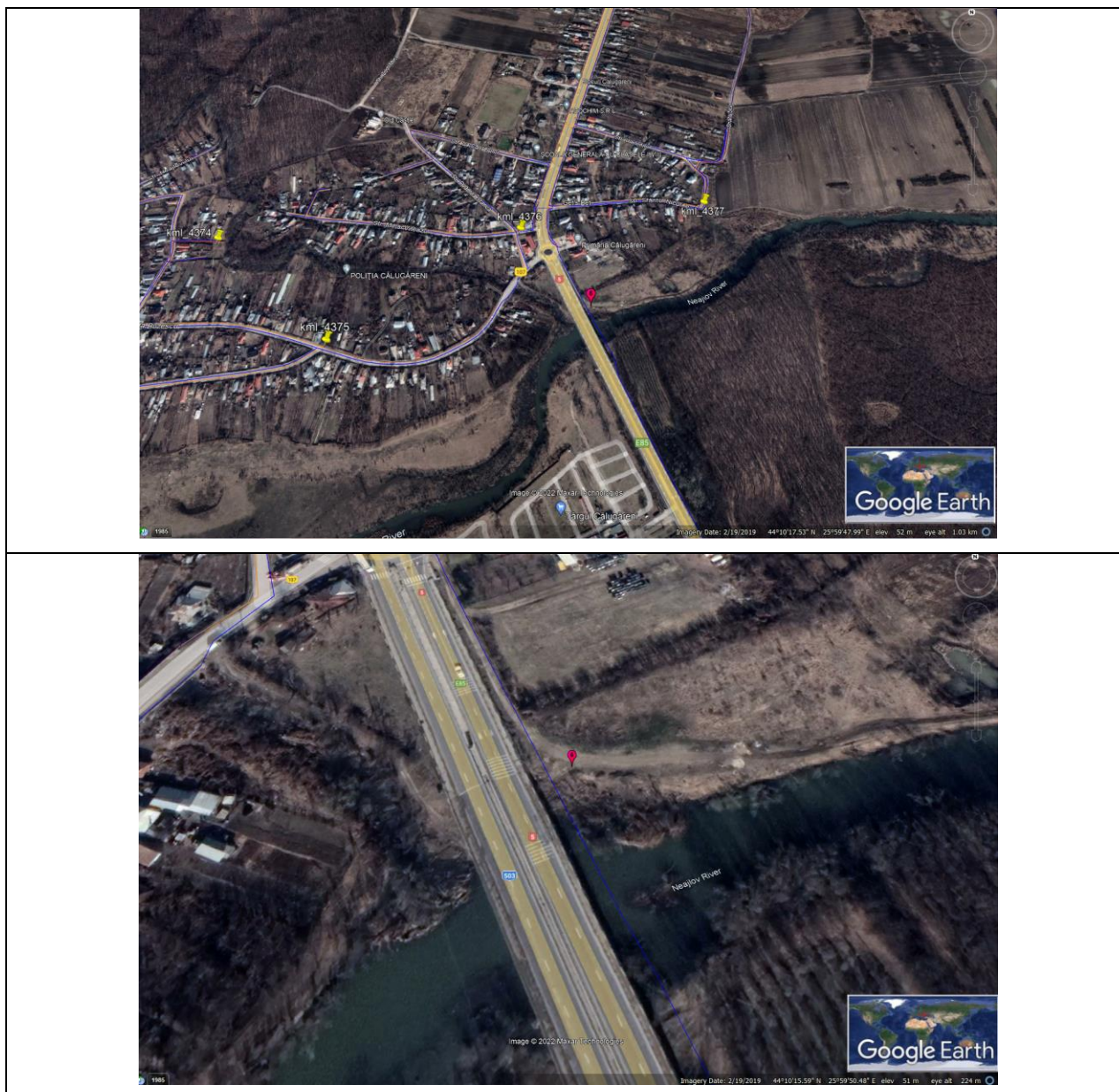
Figura 66. Stația nr. 6 – zona de subtraversare a râului Neajlov
