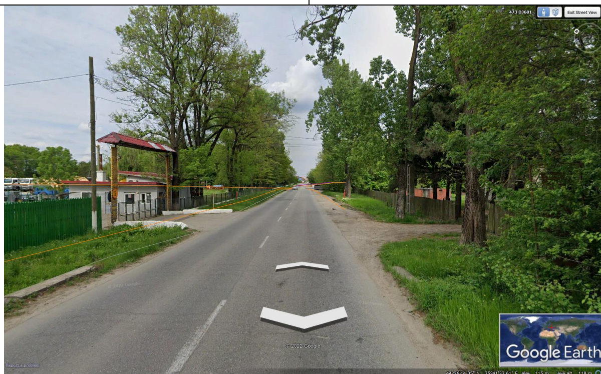
Captură Google Earth Street view a zonei fotografiate. Liniile portocalii reprezintă rețeaua de canalizare nouă proiectată.
