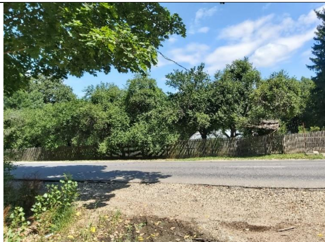
Foto 1. Construcții la marginea drumului pe traseul conductei din ampriza DJ601.
